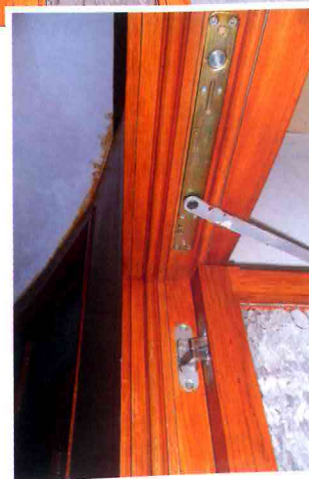
De deur werd vervaardigd van Frans eikenhout. Het bijzondere ontwerp werd ook voorzien van modern beslag, dat onzichtbaar ingewerkt werd (foto rechtsonder)
