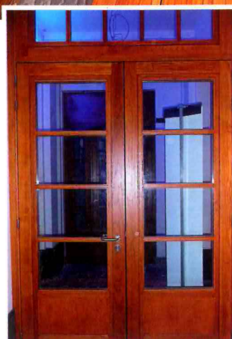
De deur werd vervaardigd van Frans eikenhout. Het bijzondere ontwerp werd ook voorzien van modern beslag, dat onzichtbaar ingewerkt werd (foto rechtsonder)
