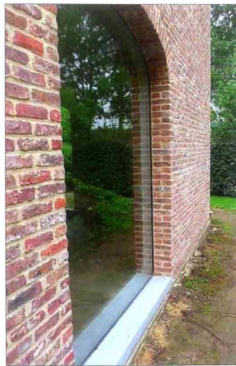
Raamwerk met onzichtbaar kaderprofiel dat het geheel een strak uitzicht geeft
