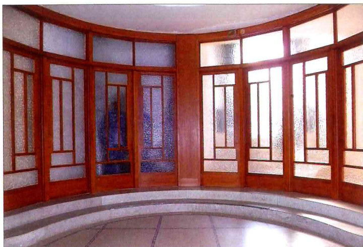
De Victor Horta-deur moest identiek zijn aan het ontwerp van de andere toegangsdeur, elders in het gebouw
